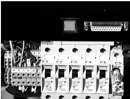
Abb. 10-29: Sicherungen rho Steuerung
